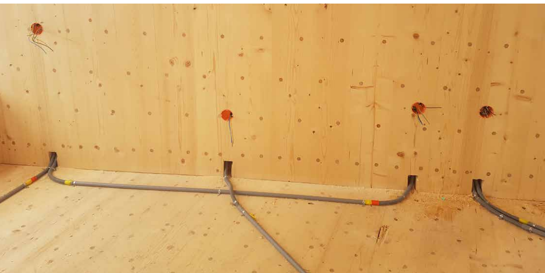
IN DIE E-SCHLITZE DER THOMA WÄNDE WERDEN AUF DER BAUSTELLE ALLE LEER-VERROHRUNGEN, KABEL UND STECKDOSEN MONTIERT.
