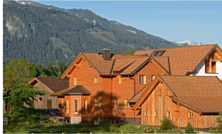
VIER FASSADEN AUF EINEN BLICK (V.L.N.R.): VORVERGRAUT, GESTRICHEN, UNBEHANDELT, KALKPUTZ
