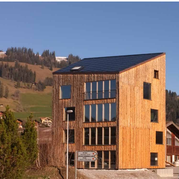
DAS HAUS OHNE HEIZUNG (WWW.N11.CH) IN ZWEISIMMEN IN DER SCHWEIZ (947 M. Ü. M.). DER 5-GESCHOSSIGE WOHNBAU WIRD KOMPLETT ÜBER PASSIVEN SONNENENERGIEGEGWINN BEHEIZT. IM GESAMTEN HAUS GIBT ES KEIN HEIZSYSTEM. REGULA UND SASCHA NENNEN IHRE ART ZU BAUEN UND ZU PLANEN DAS „SOLARE DIREKTGEWINNHAUS“.
