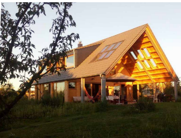
DAS HAUS VON SARAH WIENER BAUTEN WIR OHNE JEDLICHER AUSSENFASSADE UND LUFTDICHTHEITSSCHICHT MIT DER H100-W36. n_{50}=1,6 - DAS VORDACH ERSETZT DIE AUSSENFASSADE
